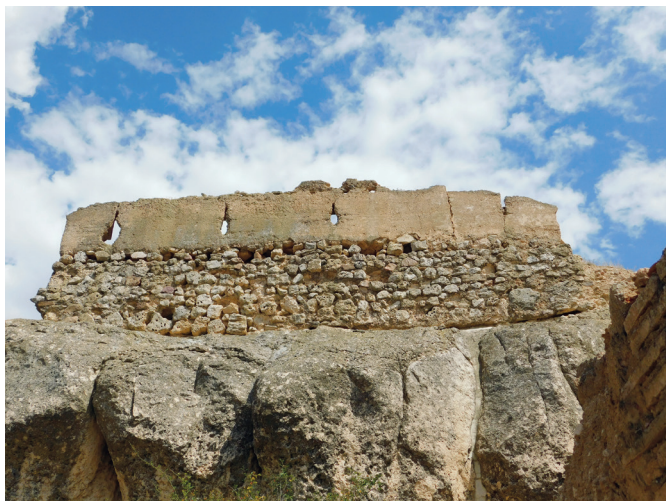
Imagen 5. Fortaleza de Langa del Castillo (Zaragoza). Detalle: elevación de la altura del muro. Fotografía: Mario Lafuente Gómez (2019).
