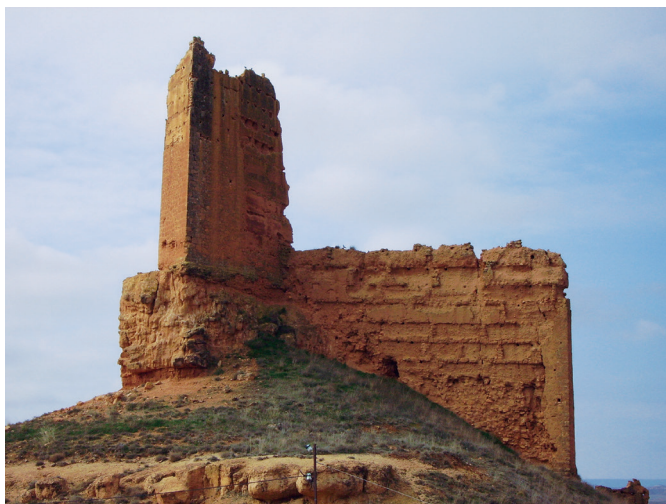
Imagen 6. Castillo de Monreal de Ariza (Zaragoza). Detalle: torre principal y lienzo con tramos de tapial y mampostería. Fotografía: Mario Lafuente Gómez (2009).
